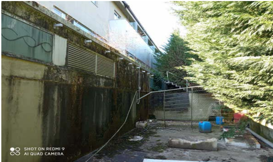
PATIO LATERAL - COCINA
